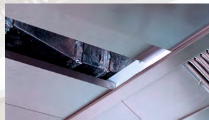
Werkzeugfreier Zugang des Deckenholraumes
