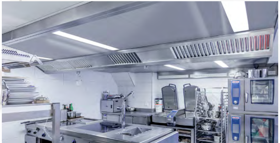
Hotel Adler, Kaiseraugst
