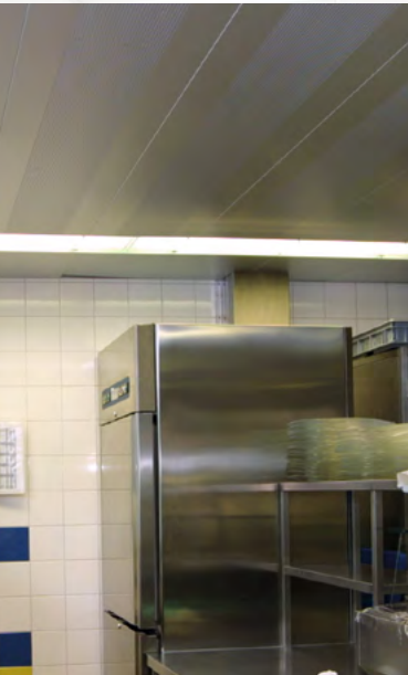
In die Zuluftdecke eingebauter Abluftfilter
