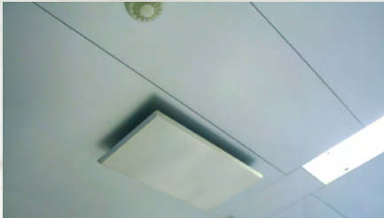
In die Zuluftdecke eingebauter Abluftfilter
